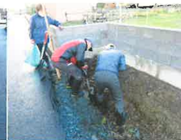
自主防災での泥上げ作業
