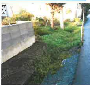
未整備の側溝現場
